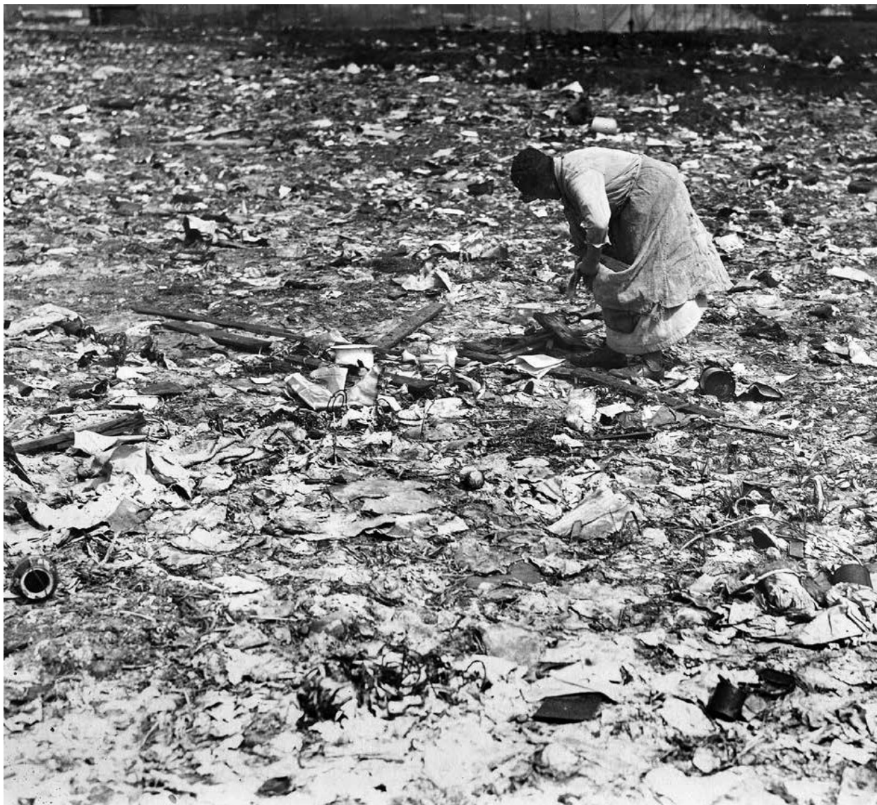
Fig. 8. En kludekælling på arbejde på lossepladsen ved Kongens Enghave i 1930'erne. Københavns Museum.
