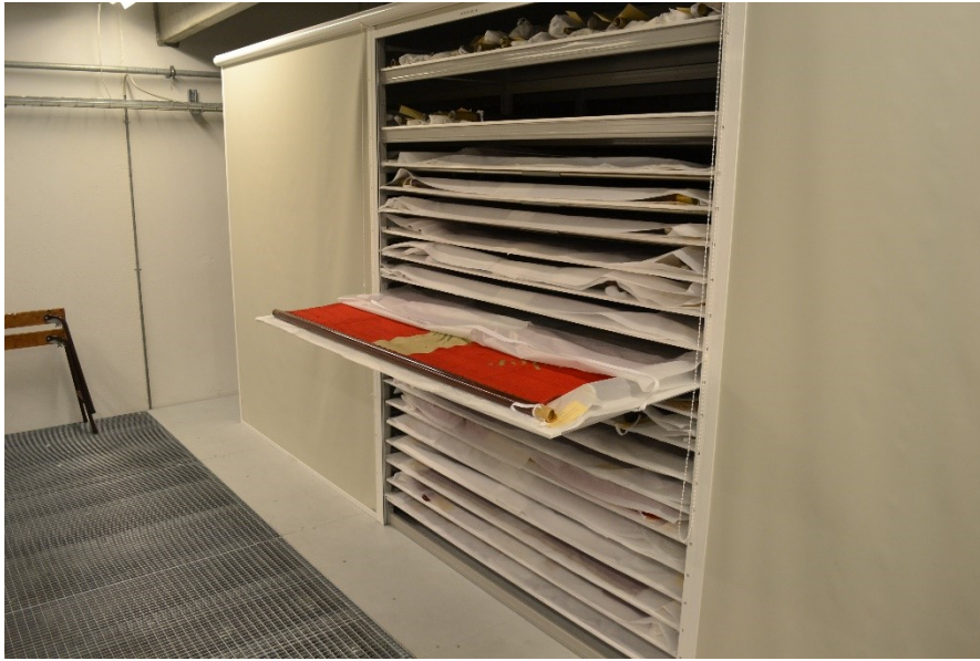
Plan opbevaring af faner uden fanestang i særligt skuffedarium – bemærk at fanestængerne opbevares på øverste hylde.
